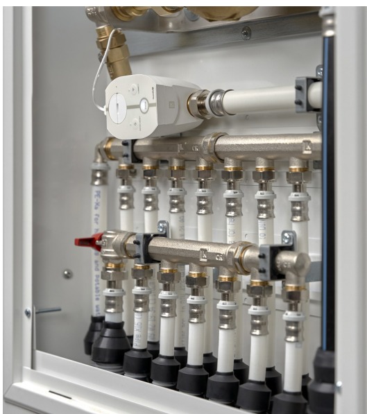
Vannstopper montert i skapet.
